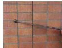
【打診棒による外壁点検】
