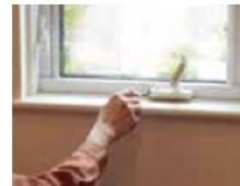
【サッシ・建具の点検】
