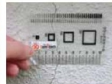
【クラックスケールによる外壁ひび割れ測定】
